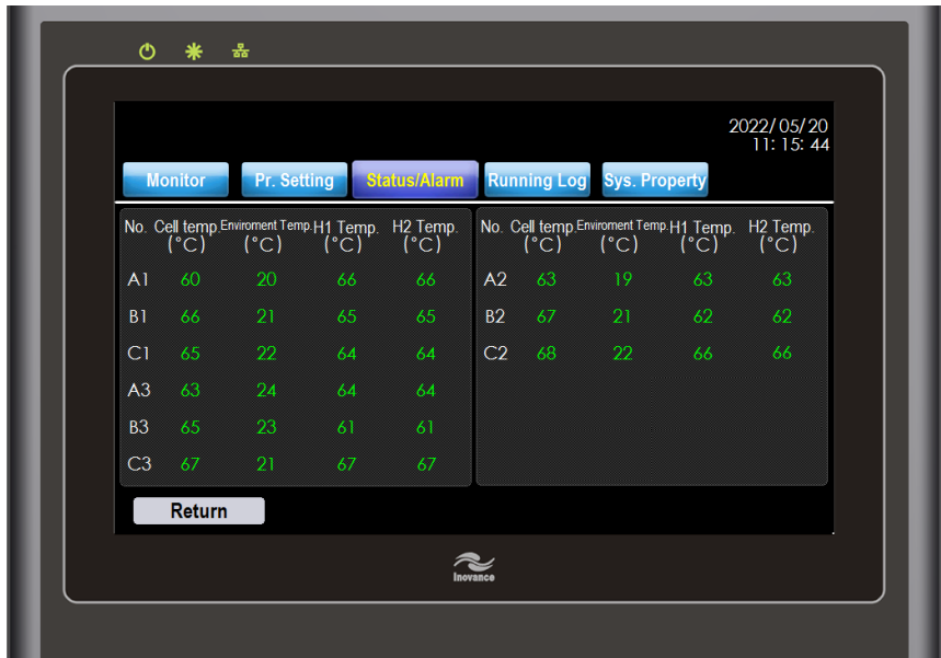
Рис. 5-22. Просмотр дополнительных данных о температуре силовых ячеек
